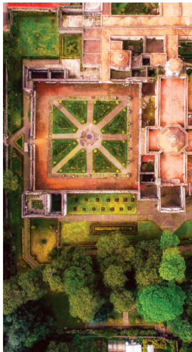
Convento Desierto de los Leones
